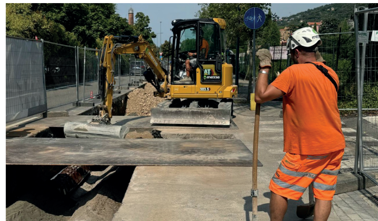
Operai in cantiere
